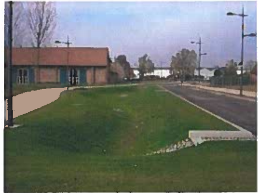
Figure 1 : Exemple de noue d'infiltration n°1
