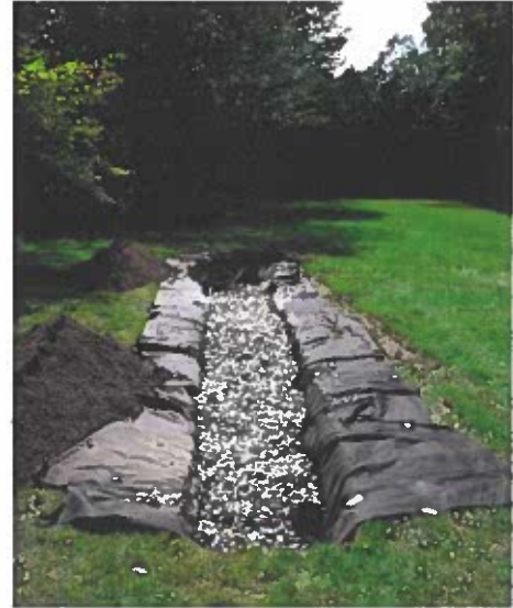
Figure 1 : Exemple de tranchée d'infiltration
